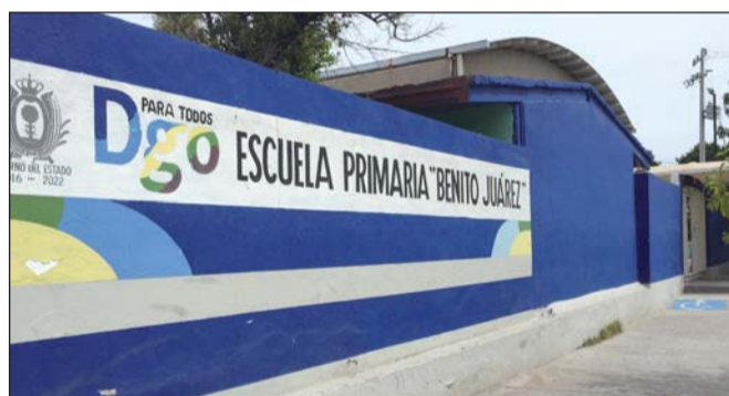
Pérdidas. Durante esta contingencia sanitaria se han registrado daños y robos en 30 escuelas de La Laguna.
